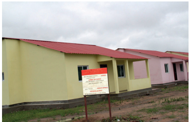
Casas sociais em construção.
