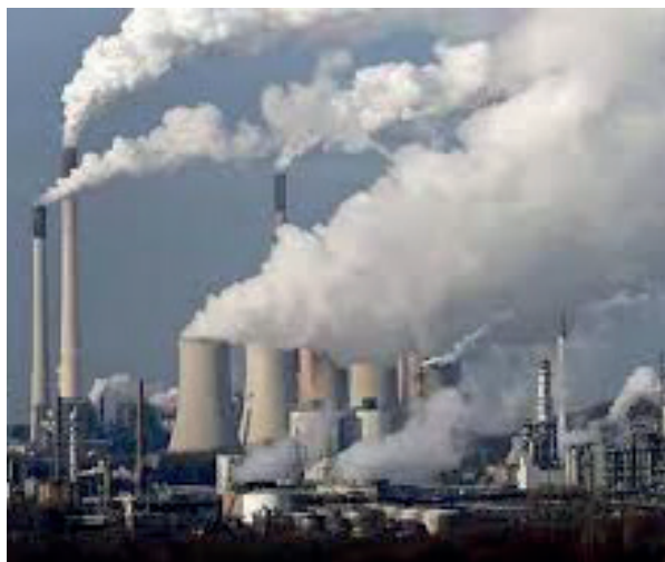
Poluição do ar, devido a actividade industrial.
