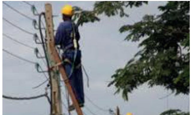
Reparação de uma linha de distribuição de electricidade.
