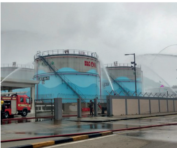
Tanque de fuel.
