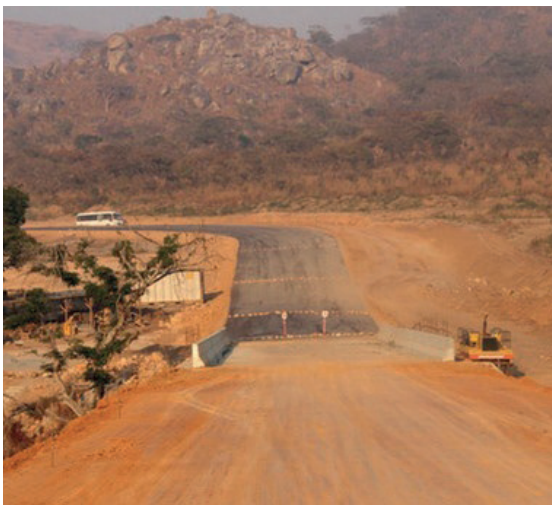
Estrada em Construção.
