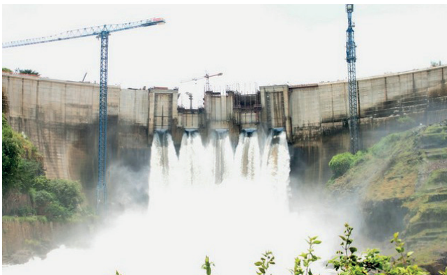
Ampliação da barragem de Cambambe - Cuanza Norte.
